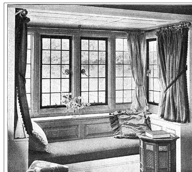
Abb. 172. Metallfenster mit Beschlag und Feststellvorrichtung.
